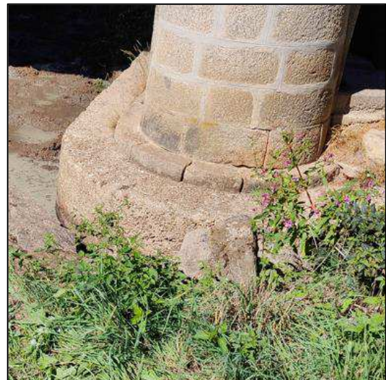
Fig. 25 – Photographie du pied de pile 1 20/09/2022 montrant la ceinture en béton
