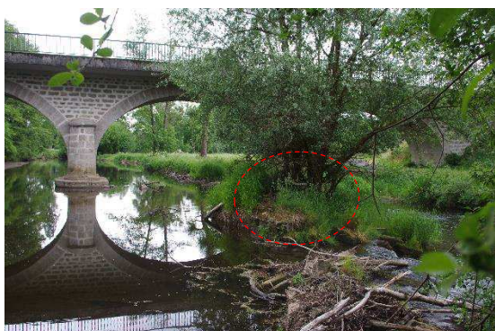
Fig. 7 - Systèmes racinaires invasifs - seuil
