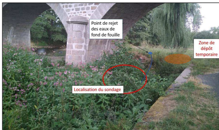
Fig. 29 – Méthodologie du sondage à la pelle
